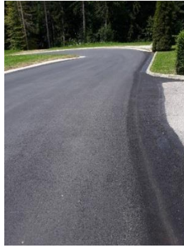
Slika 9: Saniran odsek del v naselju Križevci
