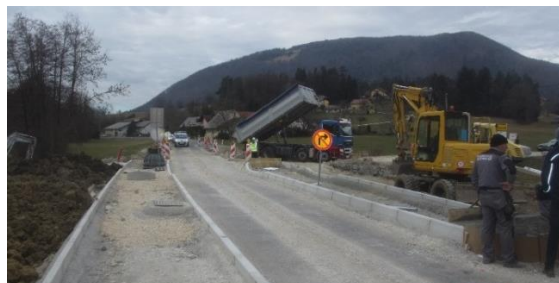
Slika 19: Izgradnja zavijalca s pločnikom »Fijavž-Korošec«
