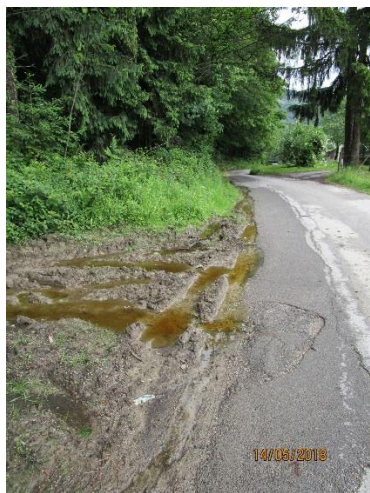
Slika 7: Poškodba bankine
