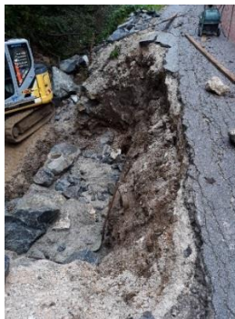
Slika 10: Sanacija usada brežine v Loški gori
