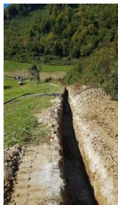
Sliki 36 in 37: Rekonstrukcija vodovoda na odseku grobovi – Kovač (Krnc)
